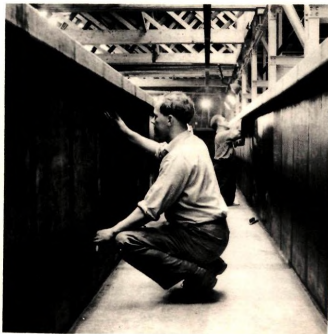
Lining a pickling vat in situ.
