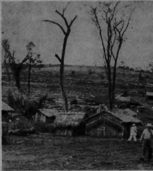
FIG. 3 OORSPRONKELIJK UIT BAMBOE OP- GETROKKEN KOLONISTENHUIZEN. Deze huizen worden door hou- ten huizen vervangen.
